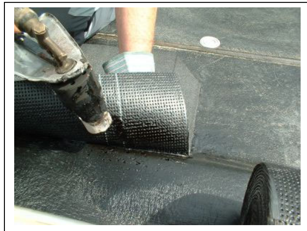
Fig. 6 met APP gemodificeerde Bitumineuze dakbedekking (de meest voorkomende materialen voor platte daken zijn met APP (Atactisch PolyPropyleen) of SBS (Styreen Butadien Styreen) gemodificeerd bitumen.
