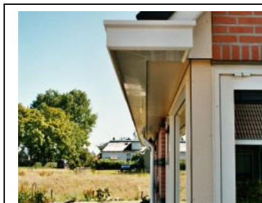
Fig. 2 glasvezelversterkte polyester dakgoot (GVP)
